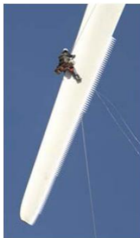
Photographie 2 Installation de serration sur une pale
